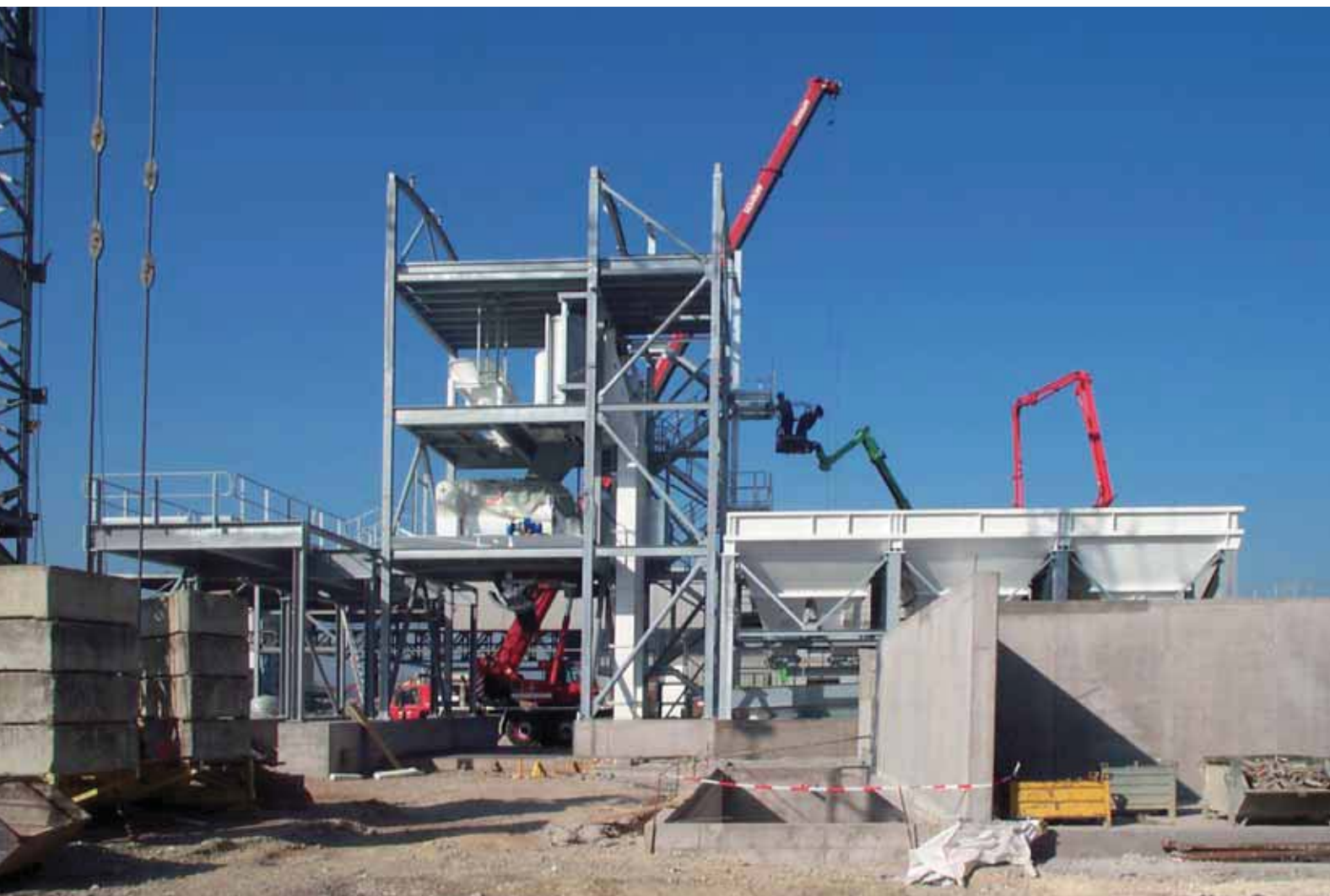
Das Transportbetonwerk bei der Entstehung
